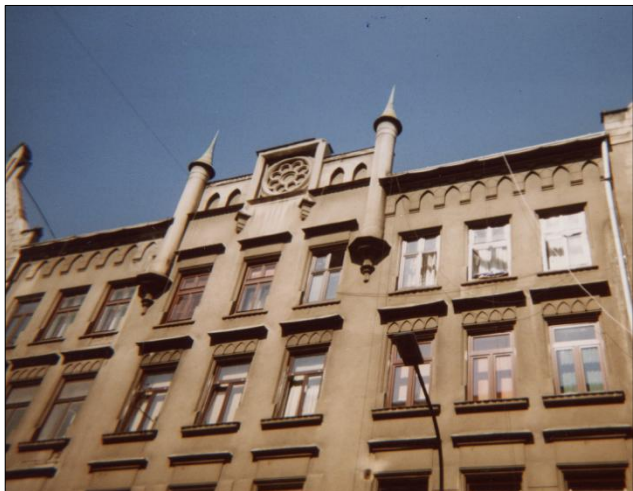
Fot. 3. Dom z minaretami przy ul. Blich. Fot. R. Kostuch
