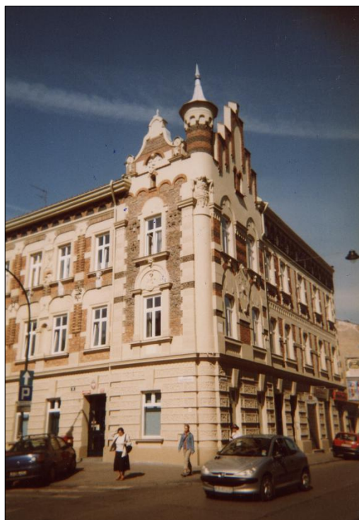
Fot. 5. Dom ozdobiony minaretem przy Rynku Kleparskim. Fot. R. Kostuch
