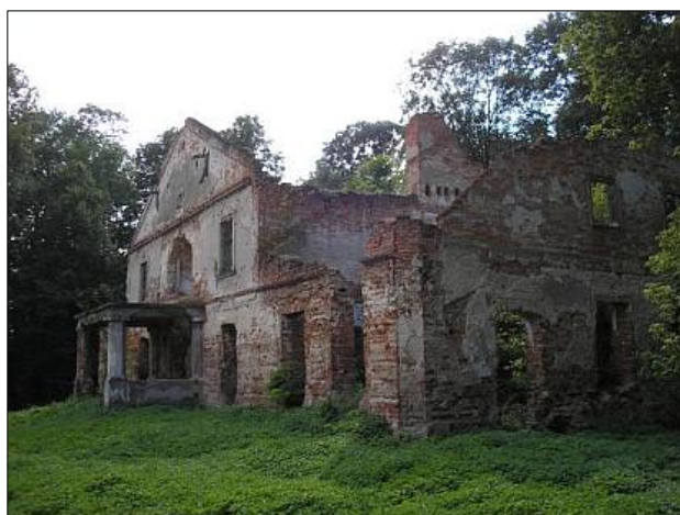
Fot. 5. Ruiny dworu w Zasowie.
