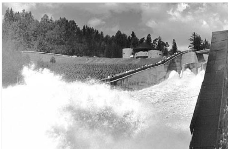
Przepusty zapory wodnej na Dunajcu w Czorsztynie podczas powodzi w lipcu 1997 r. Źródło: www.zzw-niedzica.com.pl
