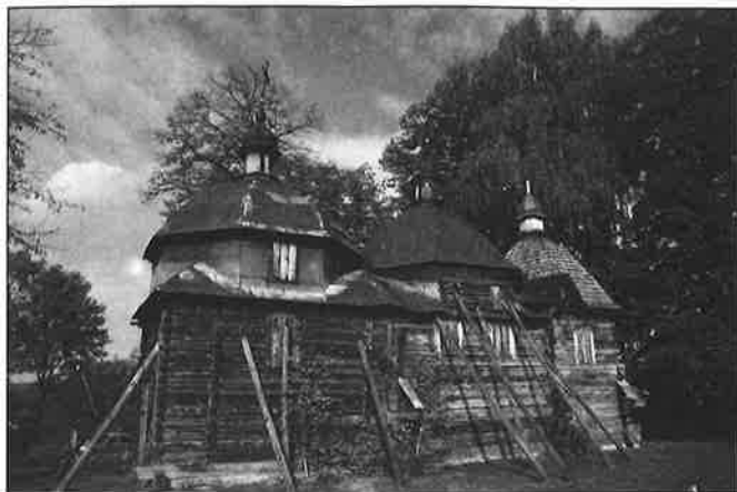
Ryc. 18. Cerkiew pw. św. Paraskewii w Nowym Bruśnie (fot. KW)
