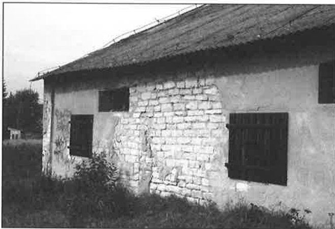
Ryc. 24. Magazyn na terenie byłego PGR w Horyńcu-Zdroju (fot. KW)
