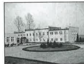
Frontowa część budynku szkoły
