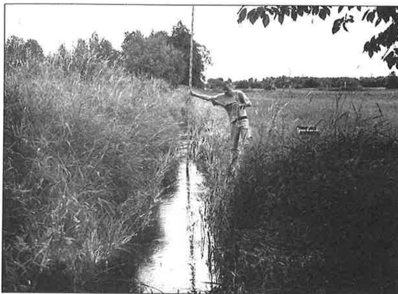
Fot. 4. Stan rowu odprowadzająco-doprowadzającego pracującego na właściwie eksploatowanej części obiektu
