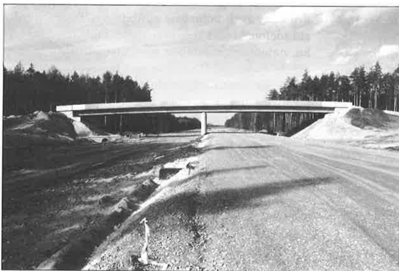
Fot. 8. Wąski na 10 m most w lasach Niemodlińskich nad autostradą A-4 (woj. opolskie) będzie mało przydatny dla zwierząt.
