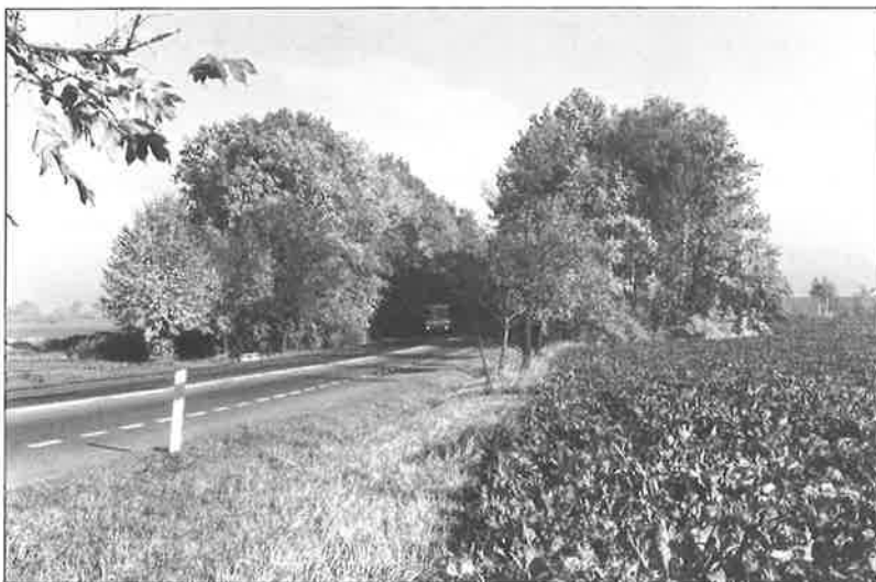
Fot. 5. Droga nr 1 Krośniewice-Kowal-Włocławek. Pasowe zadrzewienia znacząco ograniczają rozprzestrzenianie się spalin i pyłów motorzacyjnych.
